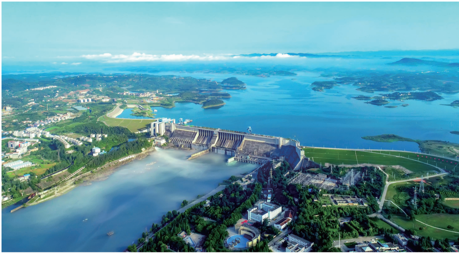
南水北调中线工程自2014年12月12日全线通水以来，累计调水量突破600亿立方米，京津冀豫四省市直接受益人口超过1.08亿人。
