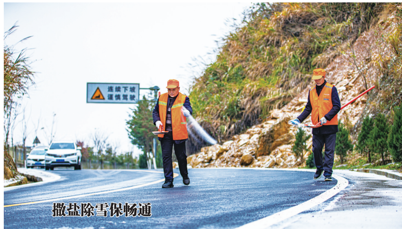
12月18日，在454省道竹山县深河乡井泉村路段，养护工人正在撒盐除雪。连日来的雨雪冰冻天气使竹山县境内公路出现结冰现象，该县公路部门及时安排养护人员在高山阴坡及弯道、桥梁易出事故处撒盐解冻，铲冰除险，确保安全通行。 通讯员章磊 摄
