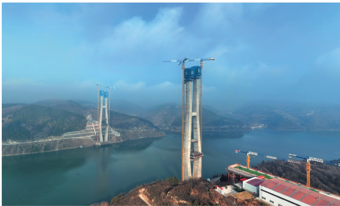
▶正在建设中的西十高铁汉江特大桥。
