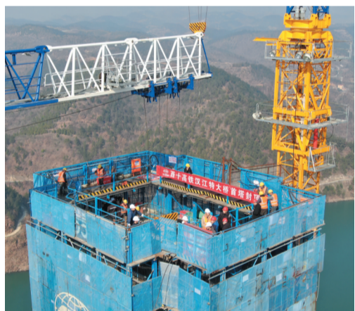
▲建设者在桥梁主塔塔顶浇筑混凝土
