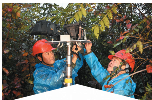
供电人员在郧西县湖北口回族乡龙王滩村山体滑坡处抢修。通讯员郝金鑫摄
