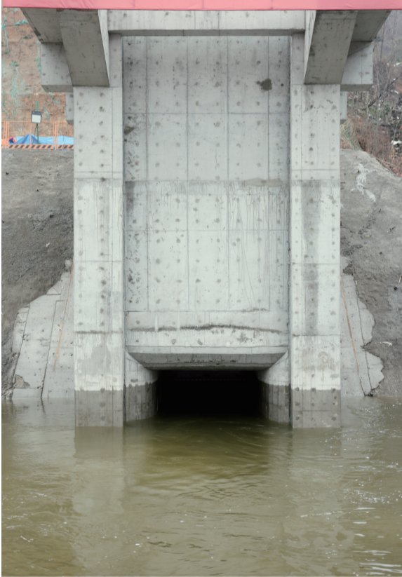
▲输水隧道开闸放水。记者刘昱 刘昆 摄 ▶工作人员在出水口等待出水。记者刘昱 刘昆 摄
