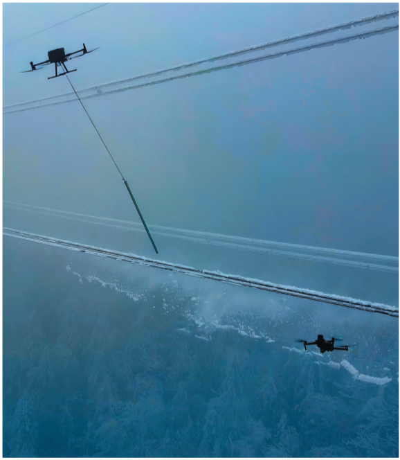
国网十堰供电公司使用无人机携带除冰棒撞击导线,消除线路覆冰隐患。记者金正 通讯员李云燕 郝金鑫摄
