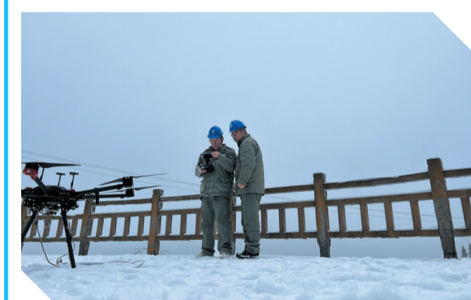
国网十堰供电公司输电运检分公司工作人员利用无人机挂载绝缘装置对220千伏十房线进行除冰。 特约记者郝鑫鑫 通讯员吴映宏 摄
