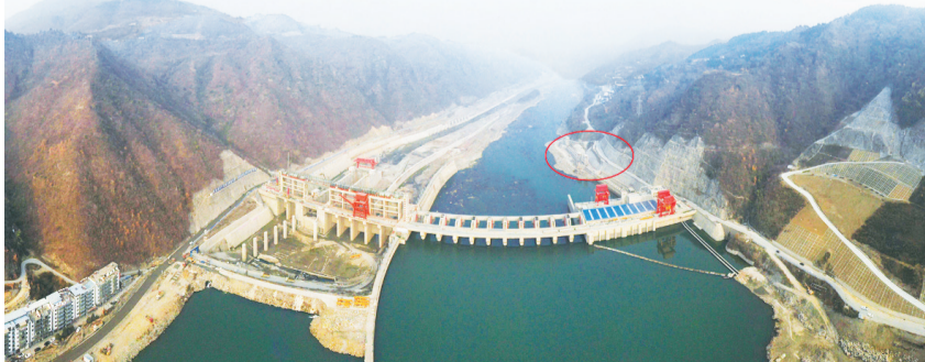
红圈处为孤山航电枢纽鱼道(资料图片)。
