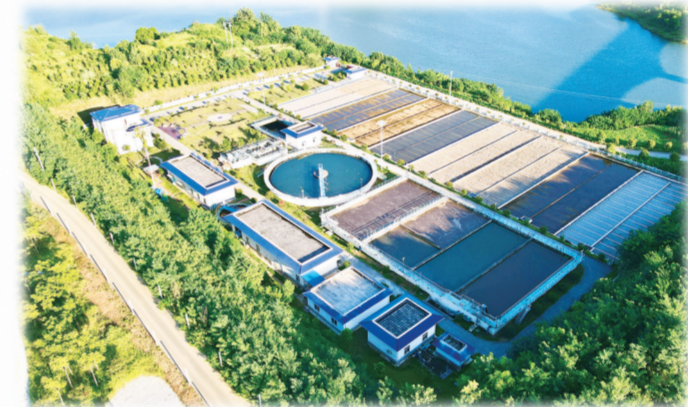
建设污水处理设施,实现污水循环利用。
