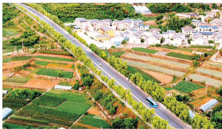
通村公交车行驶在郧阳区柳陂镇宽阔平坦的乡村公路上。记者刘旻 摄
