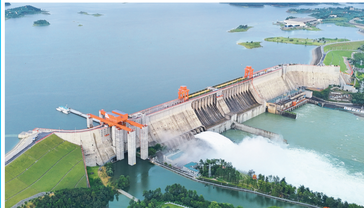
7月29日14时、18时,根据长江委调度指令,丹江口水库先后加开两个深孔闸门,向汉江中下游下泄流量由此前的2300立方米/秒分步调增至3900立方米/秒。当前,丹江口水库共开3个深孔闸门下泄腾库。截至30日14时,丹江口水库水位为162.81米。
