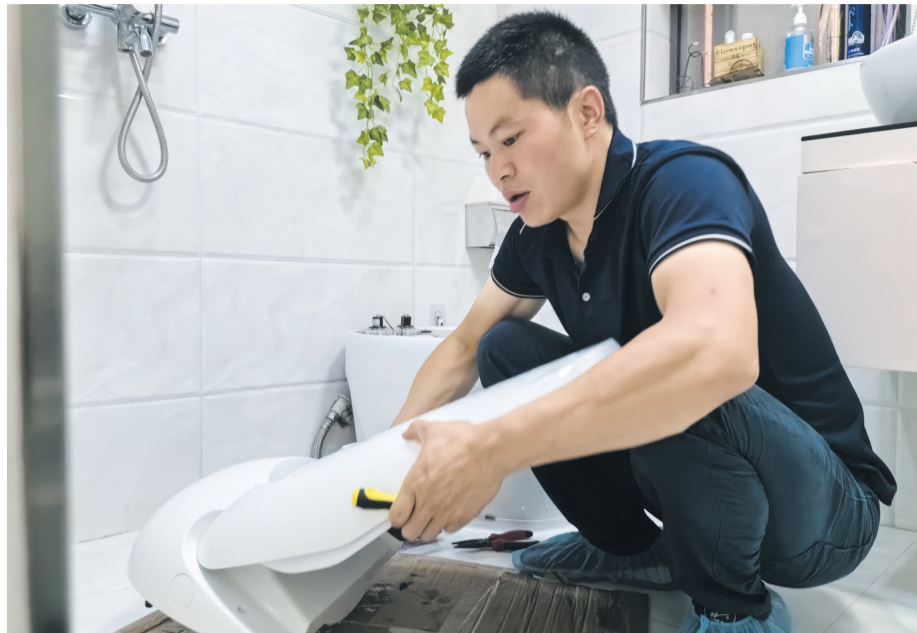
谢勇在居民家中维修马桶
