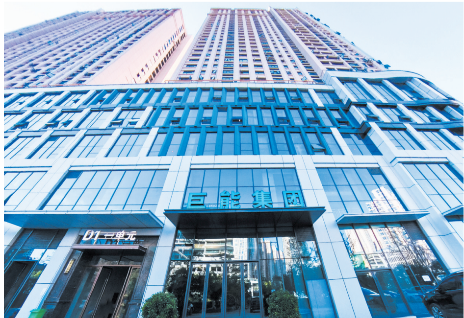
十堰巨能电力集团办公大楼
