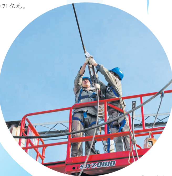
施工人员开展变电站导线接入
