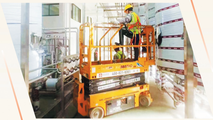
燕京精酿啤酒生产车间加紧建设
