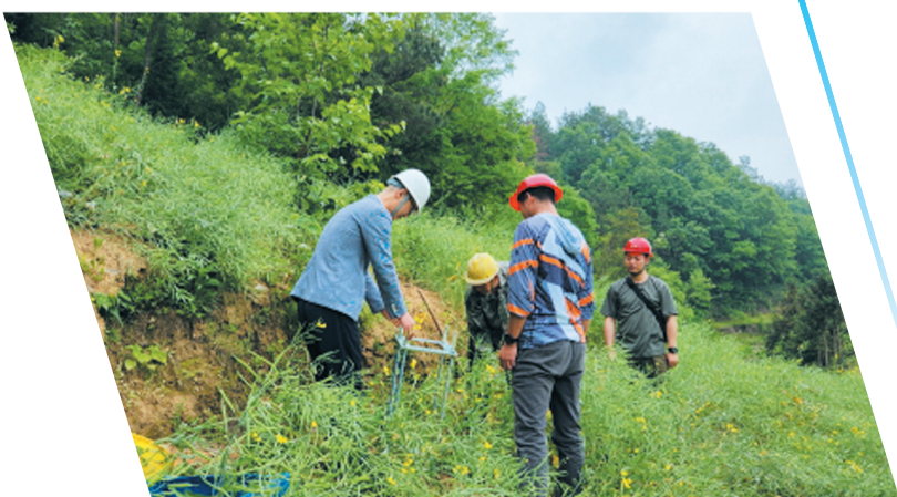
地质灾害防治网格员巡查郧西县土门镇双庙村坝下滑坡。
