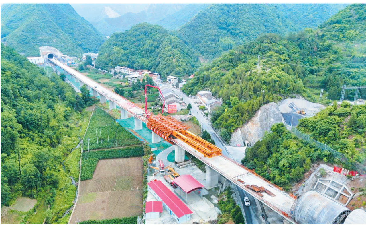
西十高铁郧西段项目建设现场。
