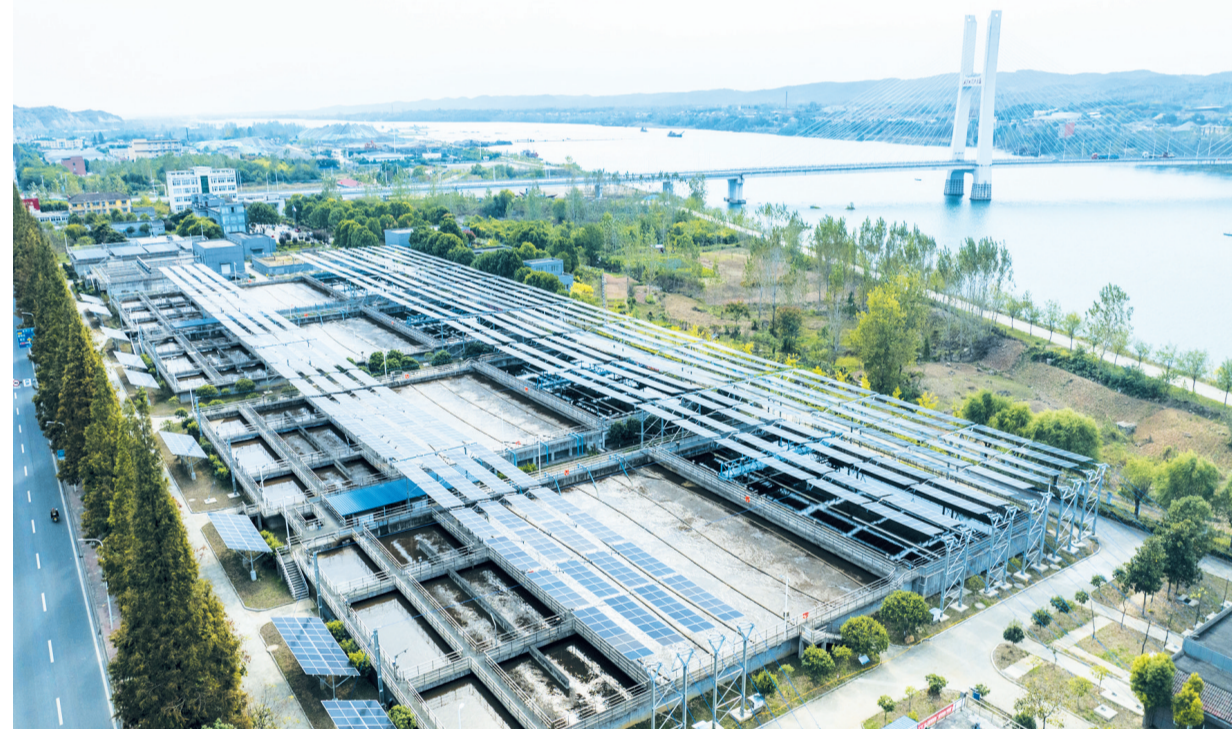
10月27日,新华社记者航拍位于十堰丹江口的中国能建葛洲坝水务(丹江口)有限公司污水处理厂分布式光伏发电项目。作为南水北调中线工程核心水源地,十堰充分利用资源禀赋和产业基础,正加快建设绿色低碳发展示范区,确保一泓清水永续北上。中国能建葛洲坝水务(丹江口)有限公司污水处理厂在国网十堰供电公司支持下,在生化池上方建设光伏电站,通过清洁能源驱动污水处理,助力绿色低碳发展。 新华社记者伍志尊 摄
