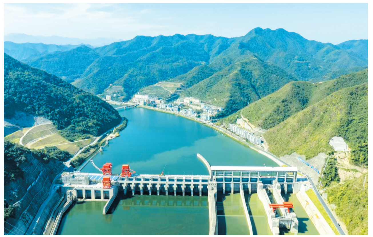
雄伟壮观的孤山航电枢纽工程。记者刘昆 摄
