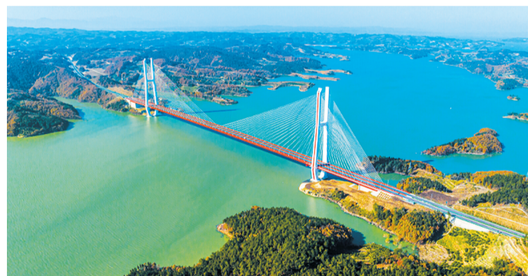
十浙高速丹江口水库特大桥于2023年1月建成通车。(资料图片)
