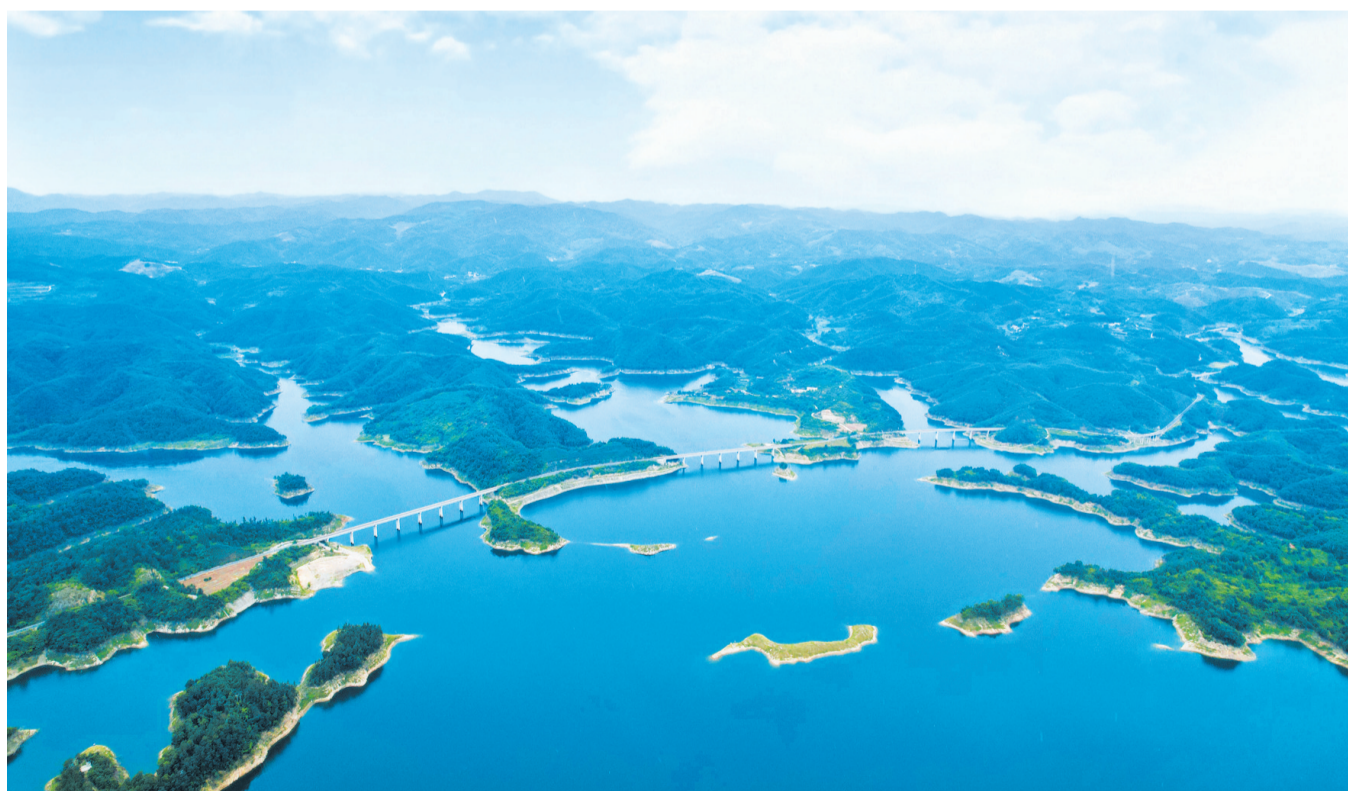
丹江口环库公路全长429公里,被誉为“中国最美山水公路”。记者全正 摄(资料图片)
