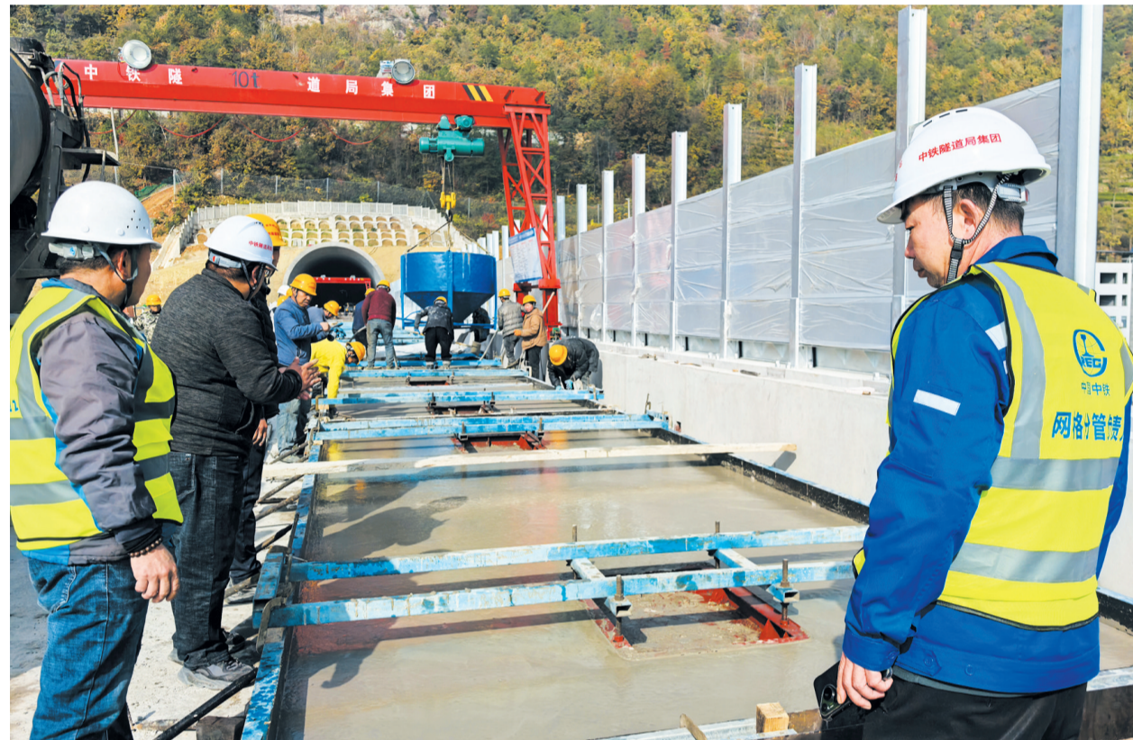
工人们抢抓工期进行无砟轨道施工。
