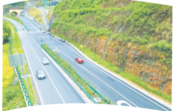
十堰城区垭子至大川一级路正式通车。记者潘世新 摄
