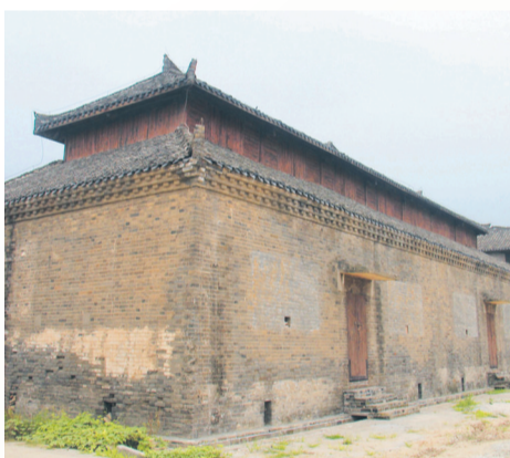
郟阳大丰仓均由青砖砌成,至今主体结构仍保存完好。特约记者曹忠宏 摄
