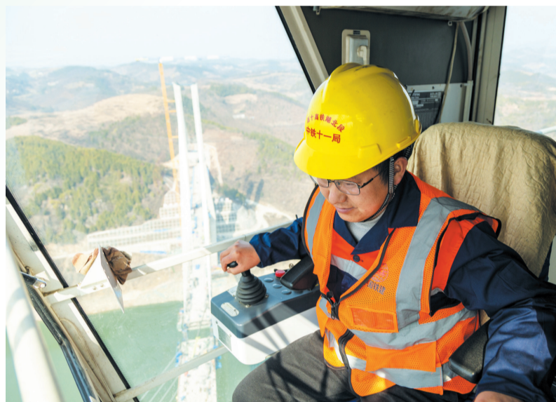
潘恒勇在塔吊驾驶室吊运物资。刘昆 摄
