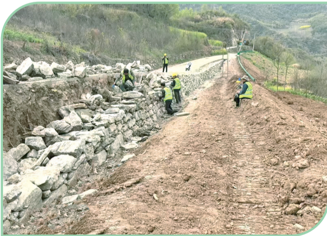
竹山县楼台乡村民参加以工代赈砌筑护坡项目。
