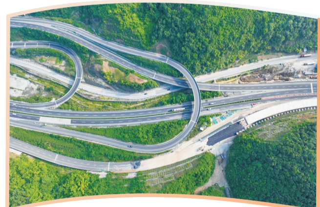
十巫北高速公路鲍峡枢纽互通项目施工现场。特约记者周家山 摄(资料图片)
