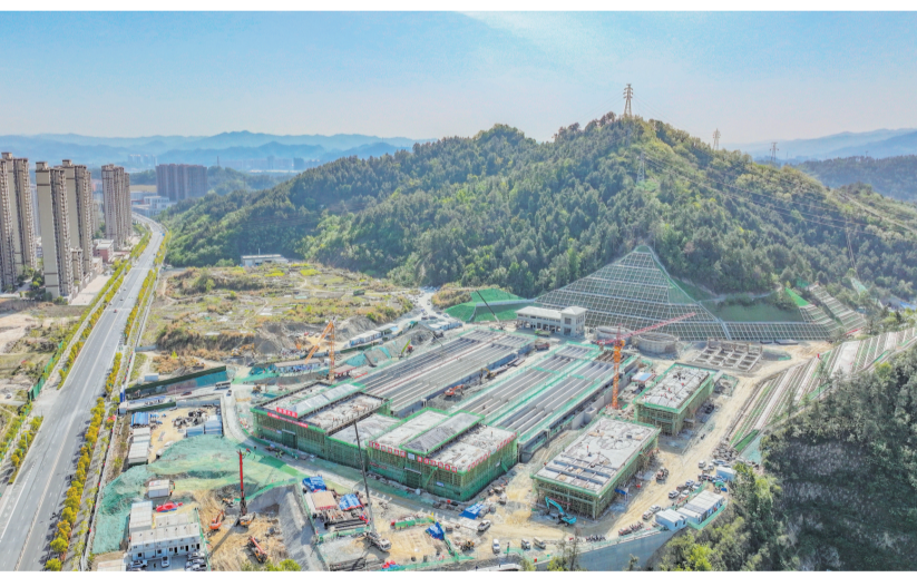
十堰城东水厂主体已全面封顶,设备设施安装加快推进。
