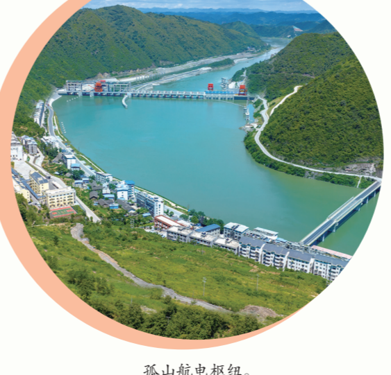
孤山航电枢纽。
