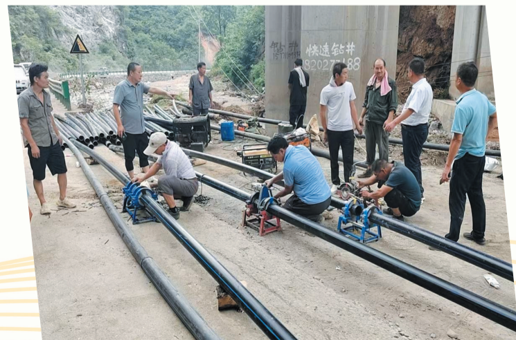
开展灾后集镇水厂管道抢修工作。
