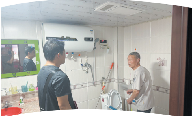
郧西县残联为残疾人进行家庭无障碍设施改造。
