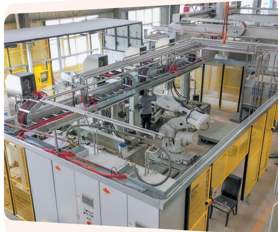
十堰高周波科工贸有限公司坚持以科技创新推动产业转型升级。
