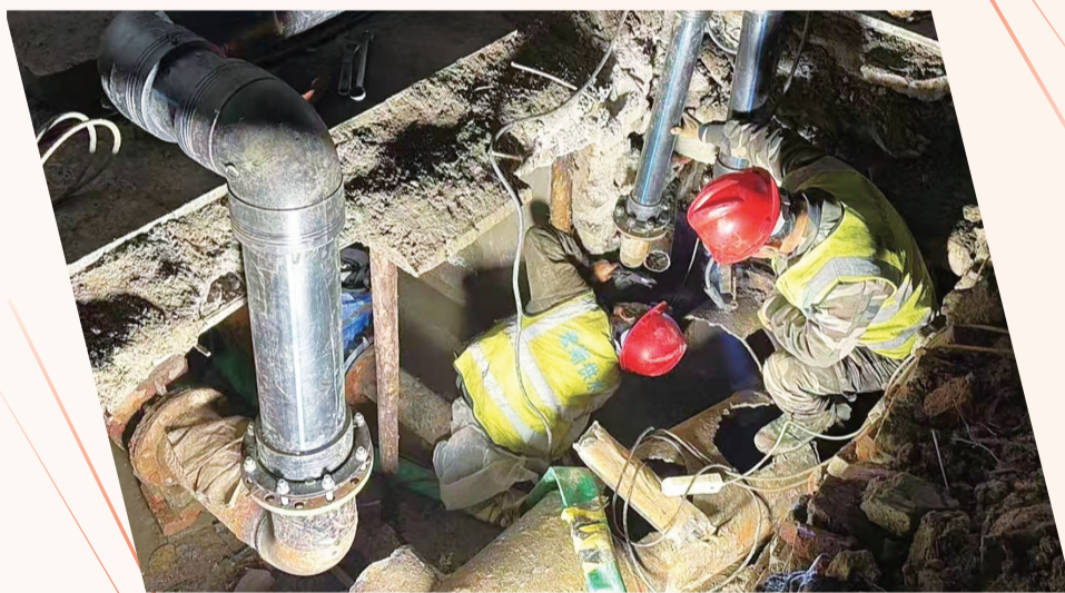
工人加班抢修地下破损管网，保障市民生活用水安全。
