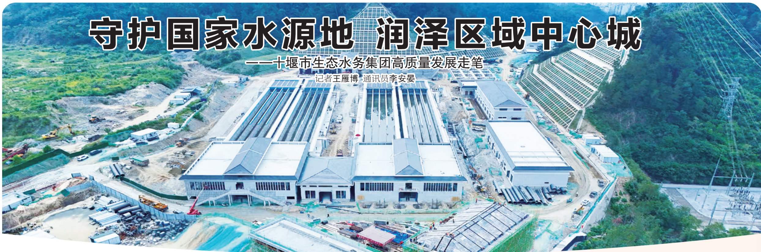
城东新水厂于2025年10月15日完成首条5万吨/日生产线试运行。
