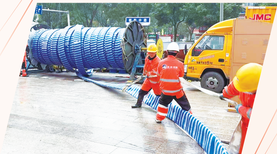
城市供水管道改造升级，提升供水服务品质。
