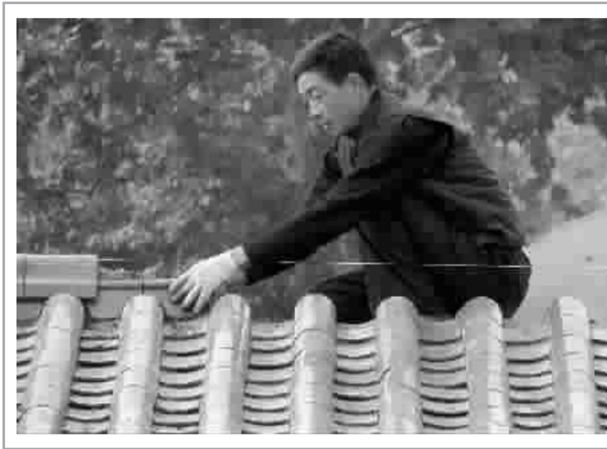
10月31日上午,郧县谭山镇腰庄村村民正在为院落围墙大门贴瓷砖、装琉璃瓦。该村在“7·24”特大洪灾中,215户房屋被冲毁。为加快房屋重建进度、确保受灾群众早日搬进新居,该县从资金、物资、技术等方面对受灾乡村给予全力支持,灾区房屋重建工作正在加快推进。 特约记者曹忠宏摄
