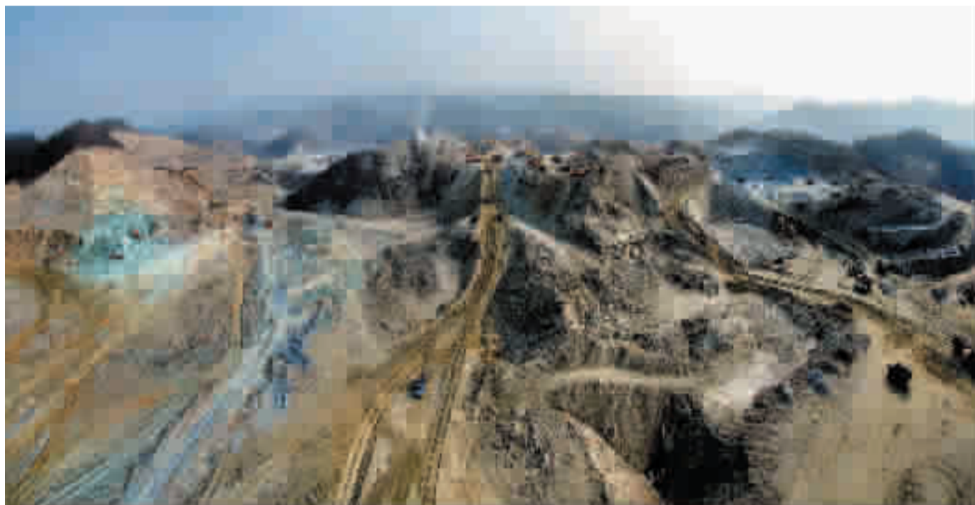
山地整理施工现场
