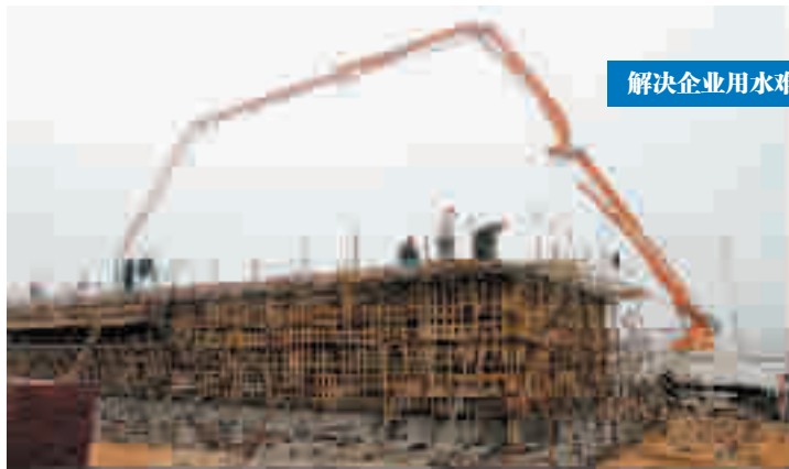
1月21日,施工人员在浇筑房县北城水厂水池。该项目投资5000万元,兴建日供水规模达5万吨的北城水厂,计划2015年12月竣工投入使用。工程完工后,可解决该县北城工业园百家企业生产用水难题。 特约记者张昌龙 通讯员孙淑芬 张华军 摄
