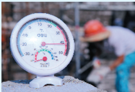
香菇小镇易地扶贫搬迁安置点建设现场,温湿度计显示为41℃
