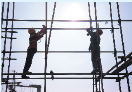
工人冒高温施工
