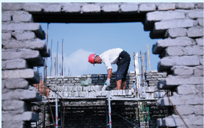
易地扶贫搬迁房屋建设加快速度
