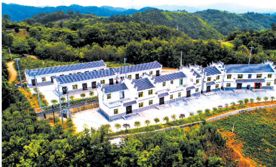
城关镇桥二沟赵家坡安置点
