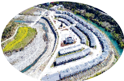
天竺乡孔家坪村易地扶贫搬迁安置点
