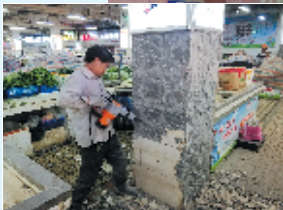
工人对墙体改造
