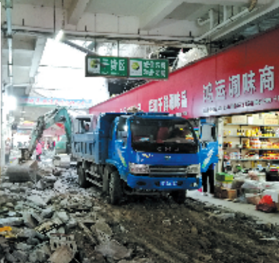
大型挖掘机在市场消防通道作业
