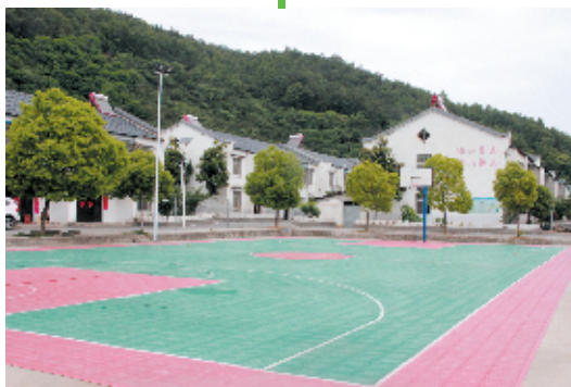
配套设施齐全的易地搬迁扶贫安置点
