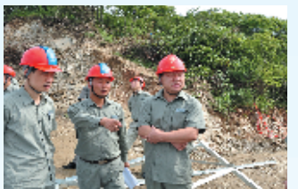
国网十堰供电公司党委书记余晓峰(右一)在施工现场检查项目进度
