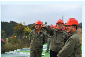
国网十堰供电公司总经理杨天功(中)到项目施工现场检查指导工作
