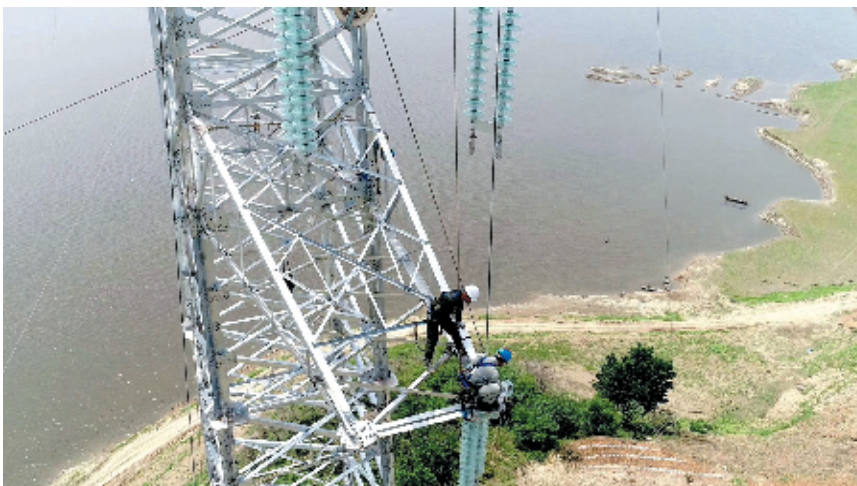
施工人员在53米的钢管塔上吊装
