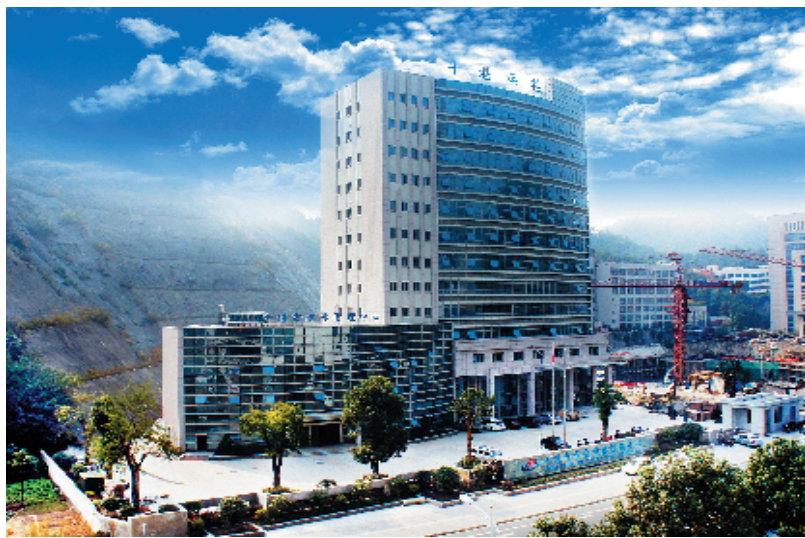
2015 年,十堰市突发公共卫生事件应急中心建设项目竣工并投入使用
