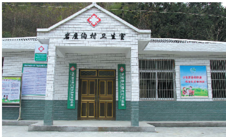
配套建设“五化”村卫生室(龙坝镇岩屋沟村)
