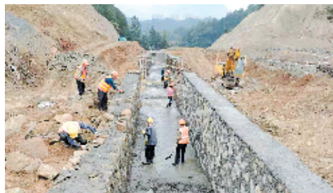
林荫大道 3 号线建设现场
