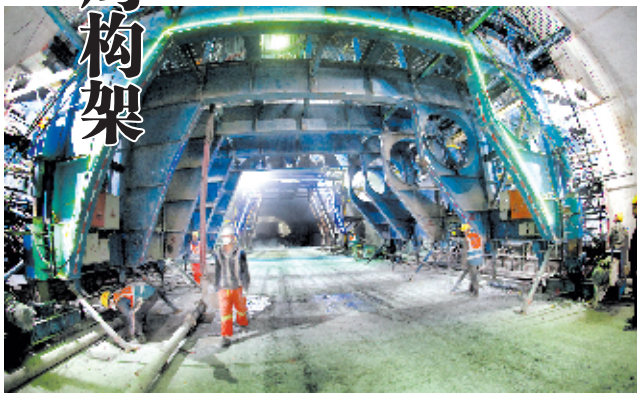
武当路复线建设现场 记者芮智敏 摄
