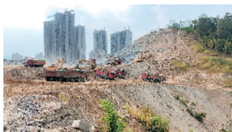
热火朝天的施工现场
