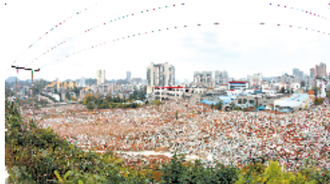
百二河生态修复项目现场 记者芮智敏 摄
