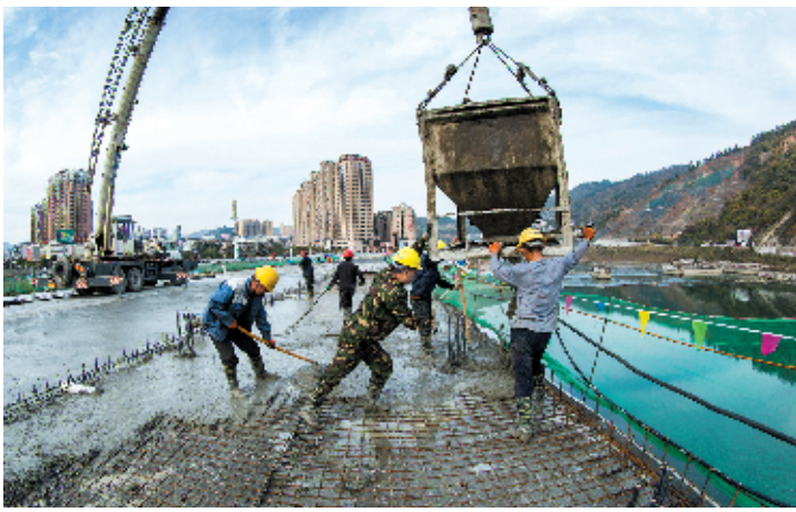
11月22日,施工人员在浇筑竹山县城关镇黄河桥桥墩混凝土桥面。据了解,黄河桥建成后,将实现东坡湾一级路、346国道、281省道的循环连接,方便塘河两岸群众出行,减轻县镇交通压力。
