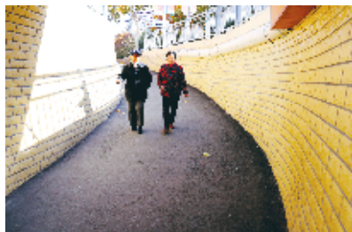
三环桥便民市场路面焕然一新。
