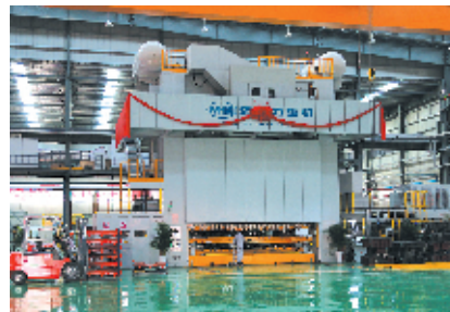
竣工投产后的东风(十堰)汽车部件有限公司自动化新工厂,鄂西北地区最为先进的同类生产线
