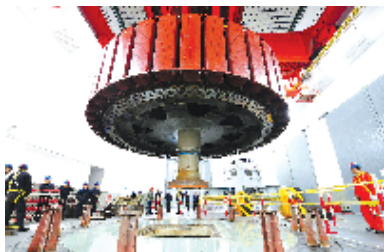
2017年10月27日,A级检修1号机吊转子
