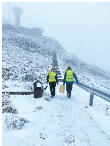
神农架维护人员到林区神农顶基站给油机送油供电
