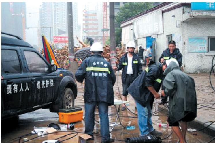
冒雨抢修光缆保通信畅通
